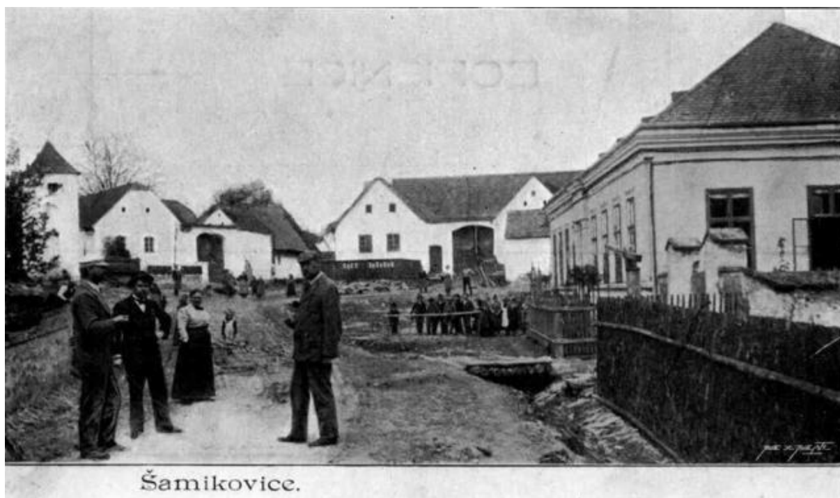
(obr. 1) Šemíkovice (dříve Šamíkovice) – nedatovaný snímek školy z přelomu 19. a 20. století, před přestavbou návěsní kaple: viditelné šambrány pouze na západní fasádě, monochromní barevnost, taška bobrovka (zdroj: www.rouchovany.cz )
